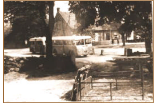
Bus und Schulgebäude
