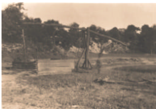
Sodbrunnen in der Sandkuhle
