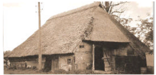
ältestes Gebäude des Ortes – umgebaut 1770 Familie Eberhardt Blick vom Innenhof
