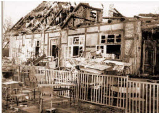
Straßenseite mit ausgeräumtem Mobilar
