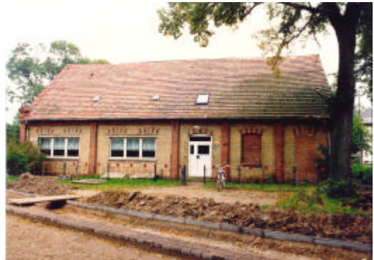
Altes Schulgebäude mit Straßenneubau
