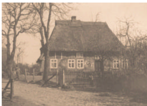
ehemaliges Schmiedegehöft an der alten Dorfstraße, erbaut um 1799
